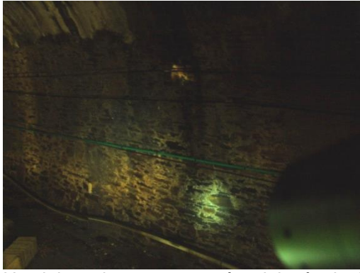
Hastiales de mampostería del túnel de Sierra Pequeña
