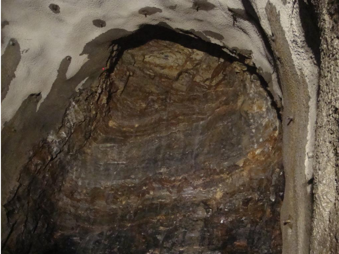
Despegue en boca Oeste. La disposición casi horizontal de la estratificación, genera la formación sistemática de techos planos.
