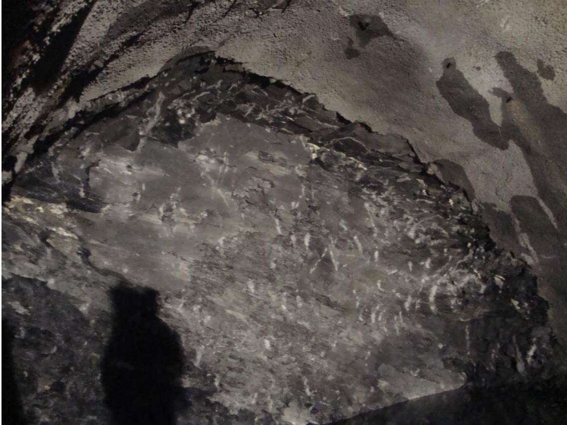
Techo inclinado en Boca Este. Despegue de lisos a favor de la estratificación
