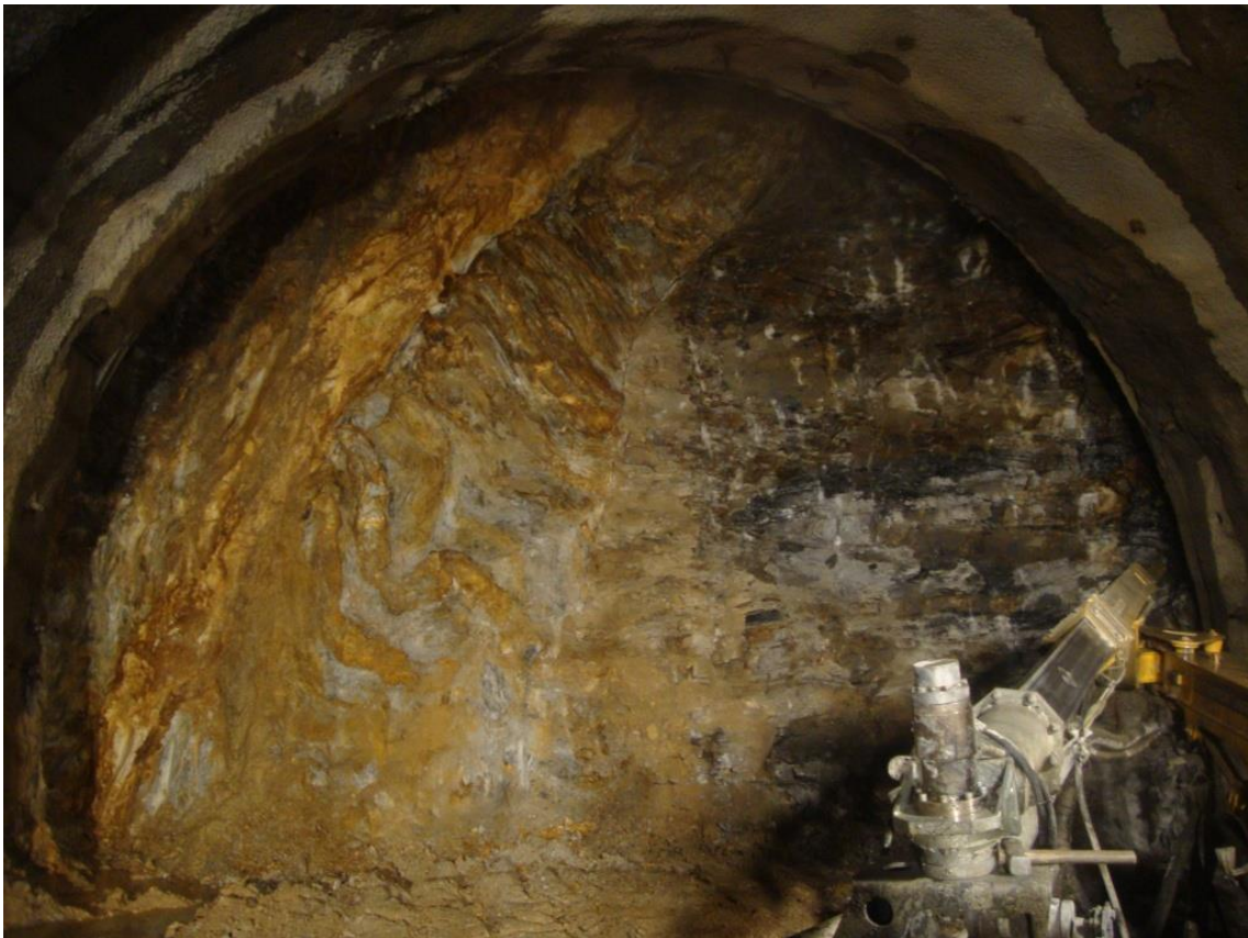
Vaciado de terreno muy localizado debido al efecto arrastre de agua. Además del importante cono de escombros a pie de frente obsérvese todo el material arrastrado.
