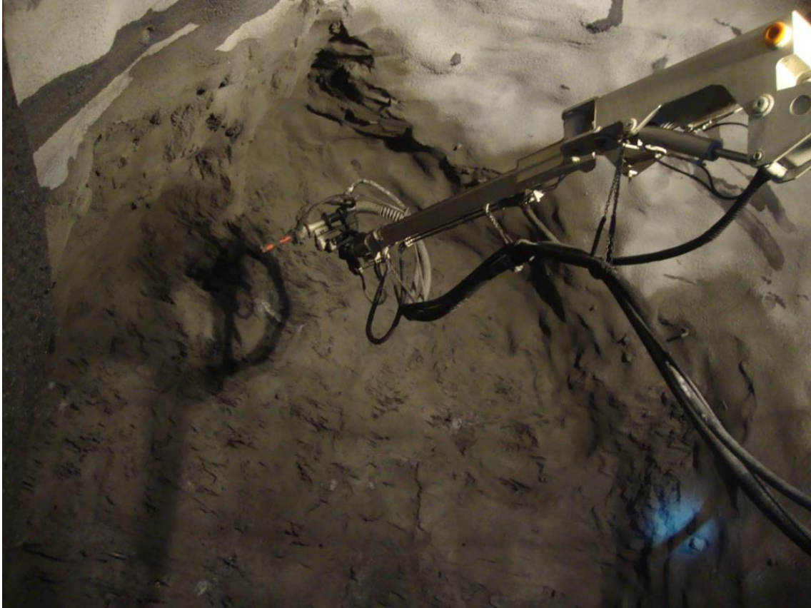
Cuña en Boca Este por la intersección de una junta de diaclasado, paralela al eje, con los estratos de filita.
