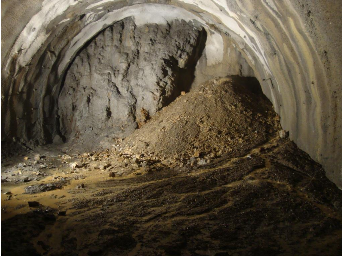
Vaciado de terreno muy localizado debido al efecto arrastre de agua. Además del importante cono de escombros a pie de frente obsérvese todo el material arrastrado.
